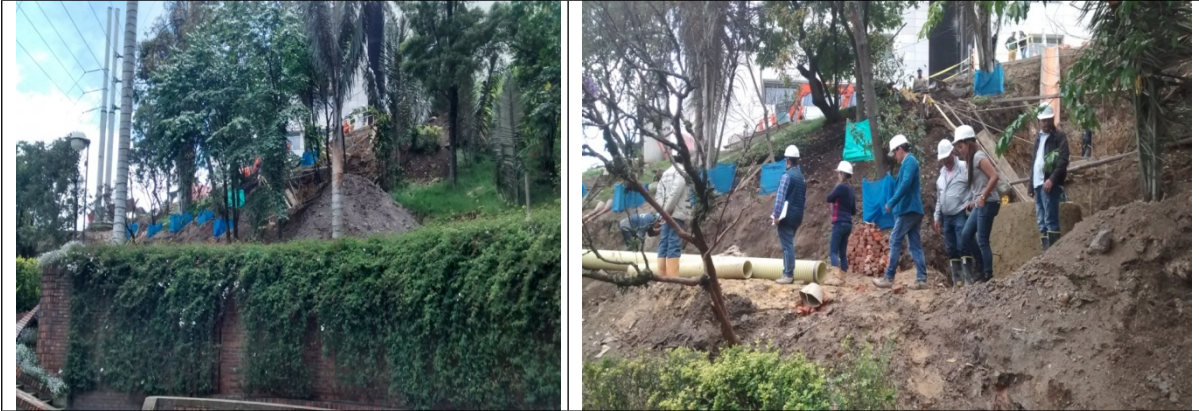
Fotos 23 y 24. Obras de conexión al sistema de drenaje urbano para evacuar el agua residual y agua lluvia del proyecto en la etapa operativa.
