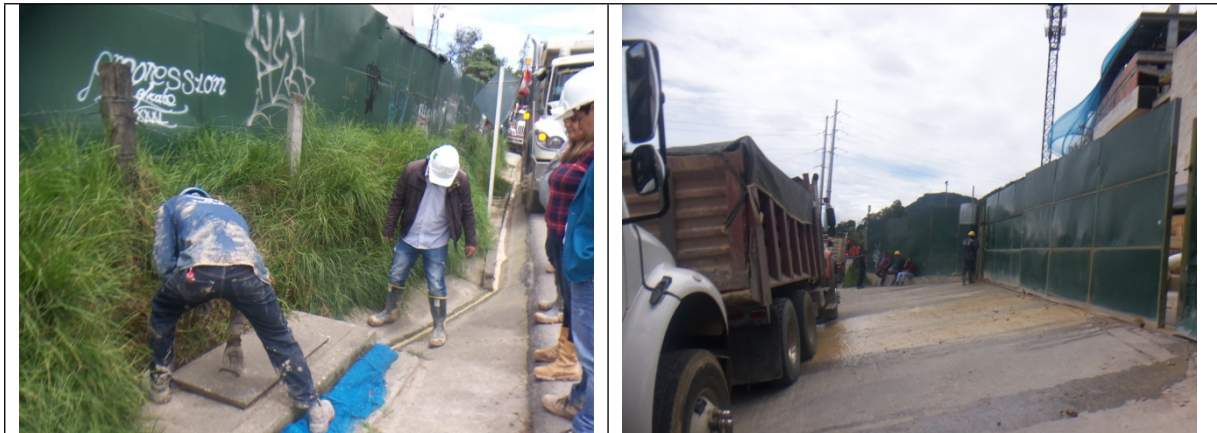
Fotos 8, 9 y 10. Se evidenció estructuras para facilitar el vertimiento de agua disuelta con sedimentos (agua lodosa). En el momento de la visita personal de la obra estaba evacuando esta agua lodosa al espacio público que conduce las mismas a componente del sistema de drenaje urbano.
