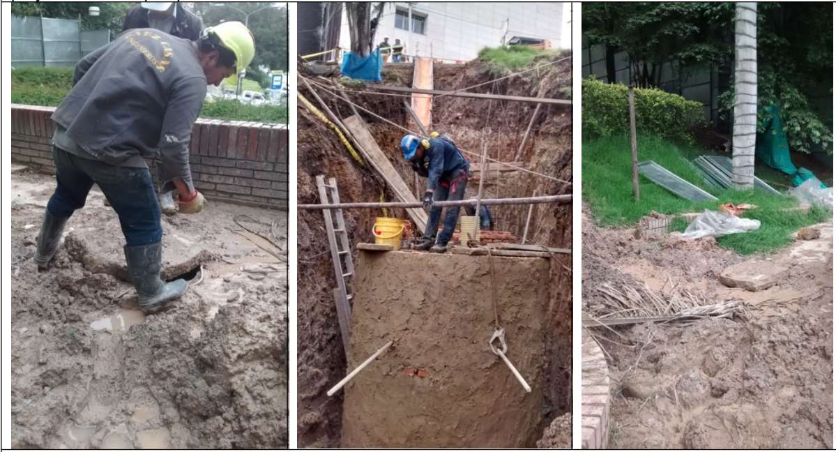
Fotos 23 y 24. Obras de conexión al sistema de drenaje urbano para evacuar el agua residual y agua lluvia del proyecto en la etapa operativa.
