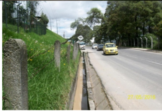
Foto 2 y 3. Recorrido del agua con sedimentos disueltos procedente de la plataforma de lavado vehicular hacia la quebrada Padre de Jesús.
