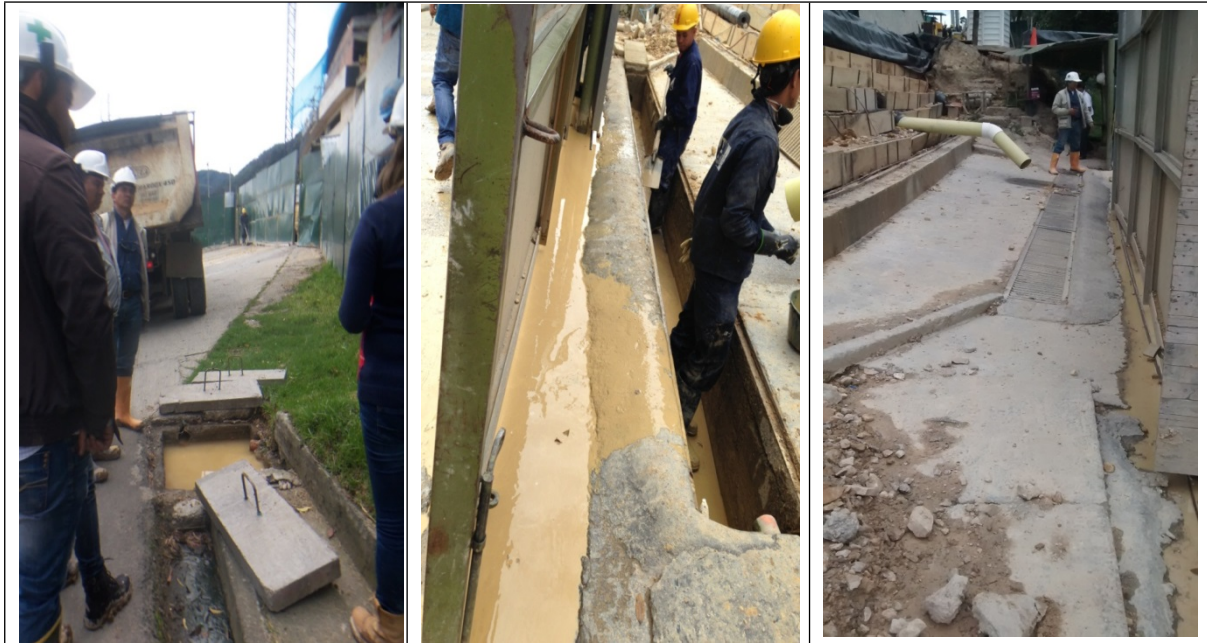
Fotos 8, 9 y 10. Se evidenció estructuras para facilitar el vertimiento de agua disuelta con sedimentos (agua lodosa). En el momento de la visita personal de la obra estaba evacuando esta agua lodosa al espacio público que conduce las mismas a componente del sistema de drenaje urbano.
