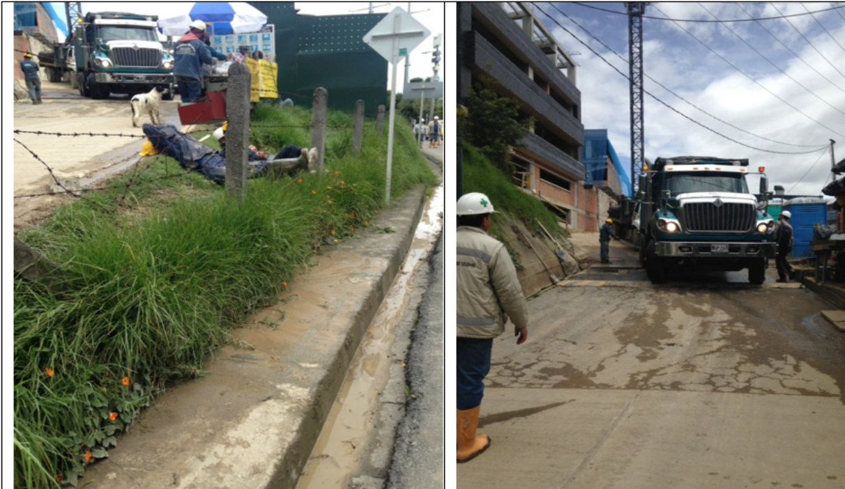
Foto 4 y 5. Recorrido del agua con sedimentos disueltos procedente de la plataforma de lavado vehicular hacia la quebrada Padre de Jesús.
